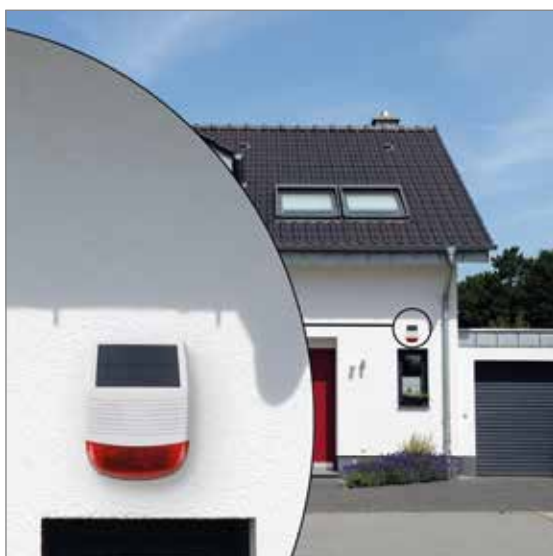
Sirene an die Hauswand montieren
